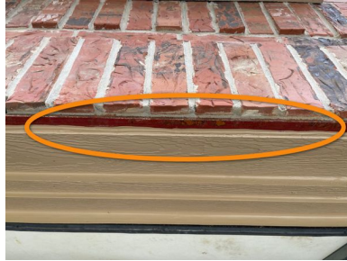
Above garage door
