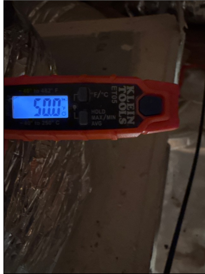
B. Item 5 Supply Side
