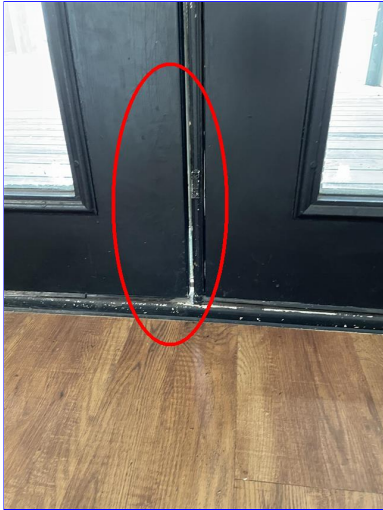
G. Item 3(Picture) Patio door
